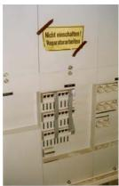
**Bild:** nachgestellte Situation beim Erneuern der Deckenbeleuchtung und der Sicherung der Ausschaltstelle
